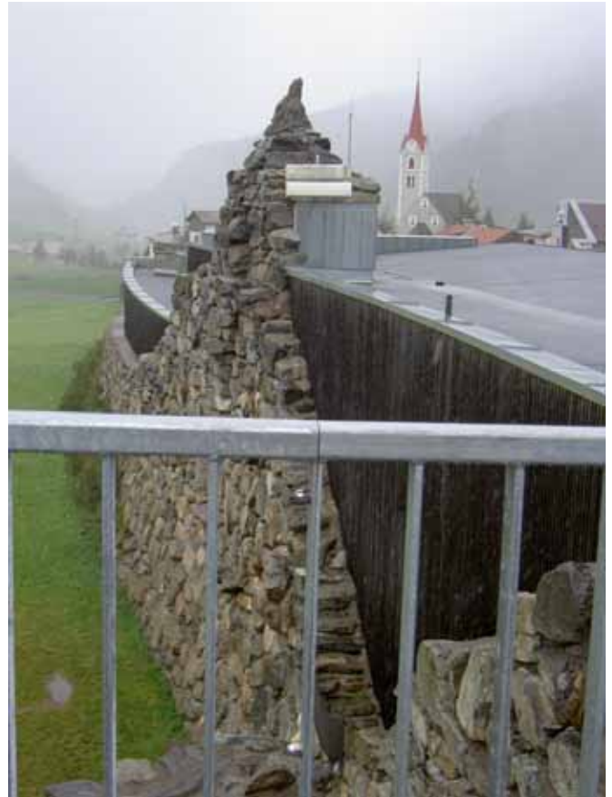
„Die Mauer“ Lawinenverbauung in Galtür, erbaut 1999.
